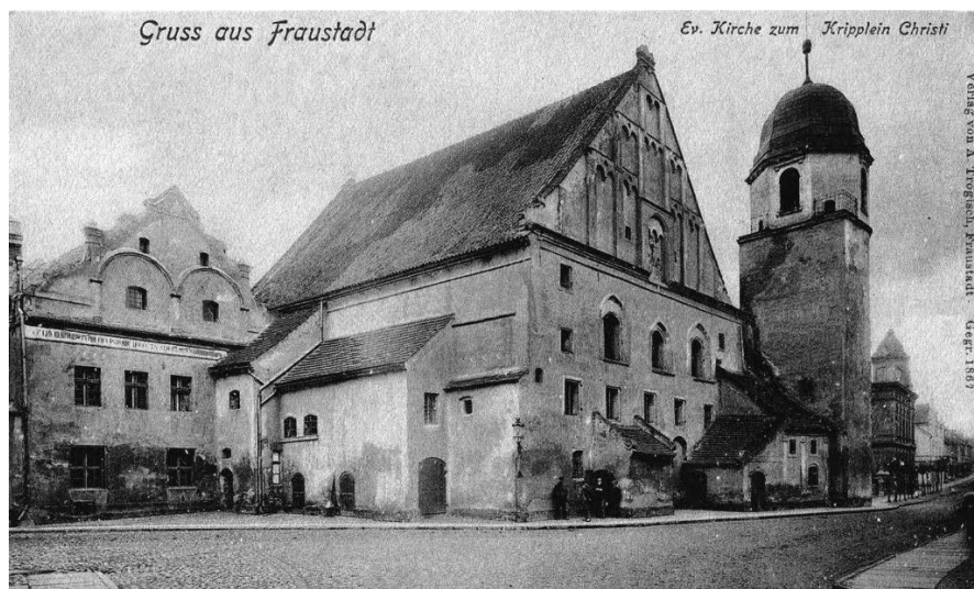
5. Kościół staromiejskiej parafii ewangelickiej Kripplein Christi z przylegającym budynkiem dawnej szkoły łacińskiej, 1903 r.
