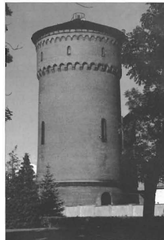
Miejska wieża wodna przy ob. ul. J. Poniatowskiego. Fot. M. Urbaniak (2008)
