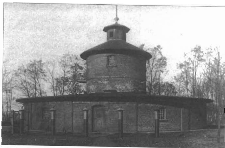
Budynek odżelazacza ze stacją filtrów wg koncepcji architektonicznej F. Salbacha Źródło: Archiwum MPWiK Sp. z o.o. w Lesznie.
