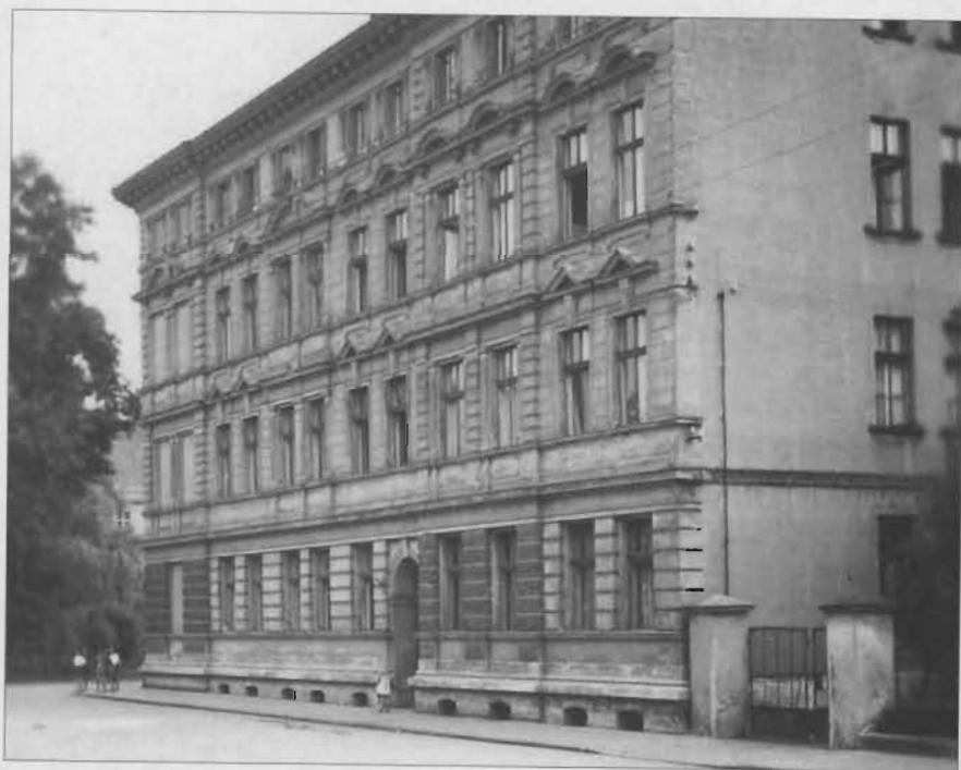
Dom przy ul. Paderewskiego. W domu tym na pierwszym piętrze mieszkał Wojtek Nawrocik, a na drugim piętrze Jerzy – autor tych wspomnień
