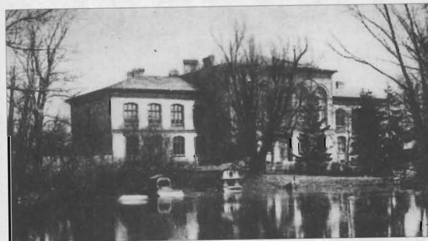
Budynek gimnazjalny przy pl. Kościuszki wybudowany w 1882 roku, siedziba szkoły żeńskiej w latach 1937–1939 i 1945–1950. Zdjęcie z połowy lat trzydziestych Źródło: ze zbiorów APL.
