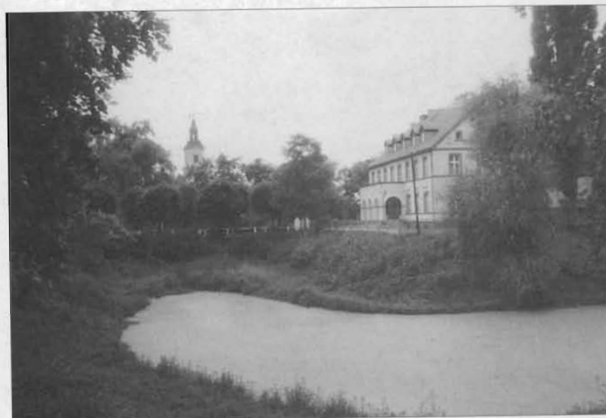
Dzisiejszy widok na wyspę zamkową od strony południowo-wschodniej. W głębi wieża kościoła farnego. Fot. W. Mielewczyk
