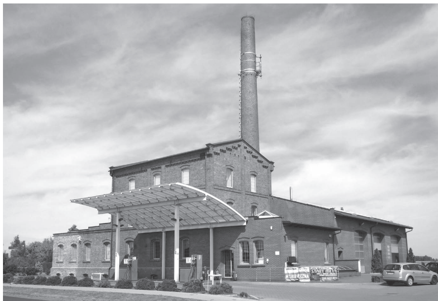
13. Budynek dawnego młyna w Wielichowie po adaptacji do nowych funkcji, 27 VIII 2015 r. Fot. Paweł Jakuboszczak
