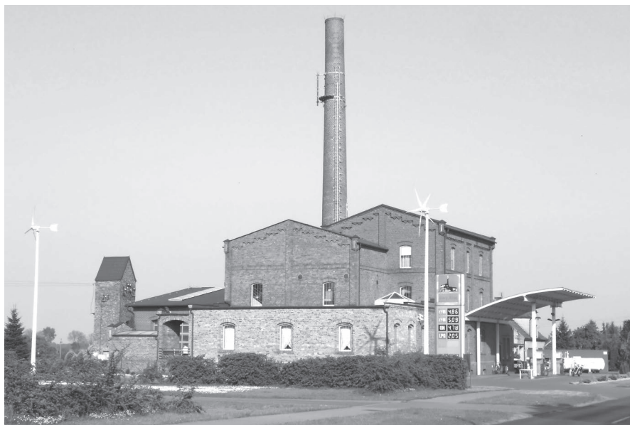
14. Widok ogólny na dawne zabudowania młyna w Wielichowie, przystosowane na potrzeby restauracji i stacji benzynowej, 29 IV 2018 r. Fot. Paweł Jakuboszczak
